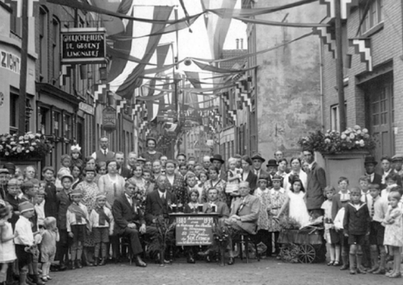
Afb. 2 Feest in de Barlheze ter gelegenheid van de vijftigste verjaardag van koningin Wilhelmina in 1930. Aan de linkerkant is nog een klein gedeelte van het café van Hoegen Dijkhof (voorheen De Vries) zichtbaar. Daarnaast, met het rechthoekige uithangbord (Grolsche Bieren – De Groen's Limonades) is café Ooms. Enkele huizen verder is het burgerhotel van Vermeulen. Vooraan rechts is een klein gedeelte zichtbaar van de boerderij die De Jonge hier rond 1925 had laten bouwen. (collectie S. Schouten)
